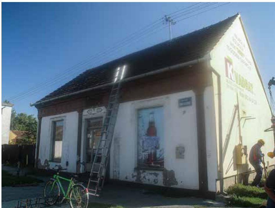
Slika 113. Radnici HEP – a Valpovo pripremaju premještanje električnih vodova 2.11.2010. godine zbog predstojećeg rušenja zgrade
