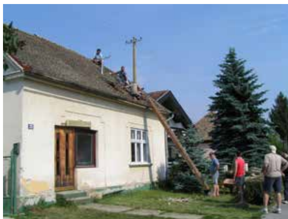
Slika 148. Kuća obitelji Đure Binski
